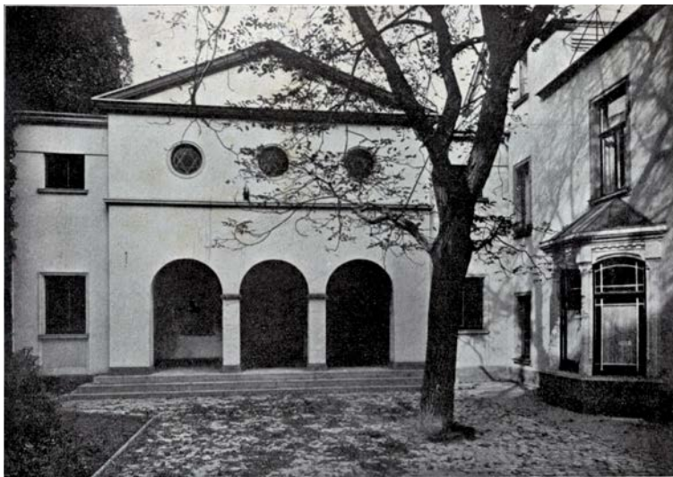
Synagoge Köln-Ehrenfeld, Frontalansicht mit Vorhof. Robert Stern, Architekt BDA., Köln.
